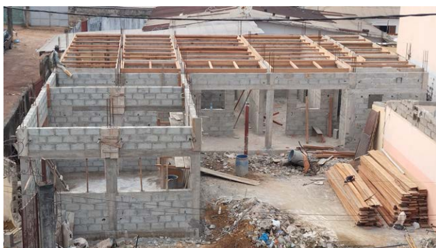
Le chantier de Notre-Dame-de-la-Providence en avril 2024
