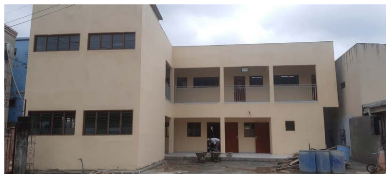
Le chantier presque achevé des classes du lycée en septembre 2024
