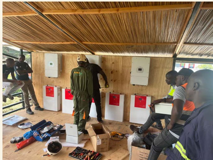
Chantier d'installation de panneaux solaires
