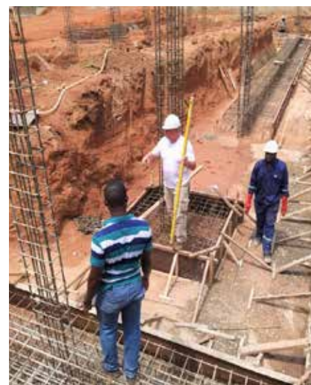
Maître d'oeuvre toujours présent sur le chantier
