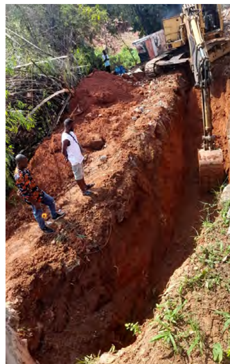
Ouverture des fondations.
