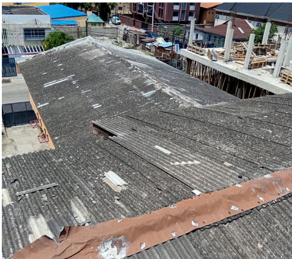
Les deux toits des deux bâtiments (tout rapéciés au cours des ans) vus depuis le château d'eau.
